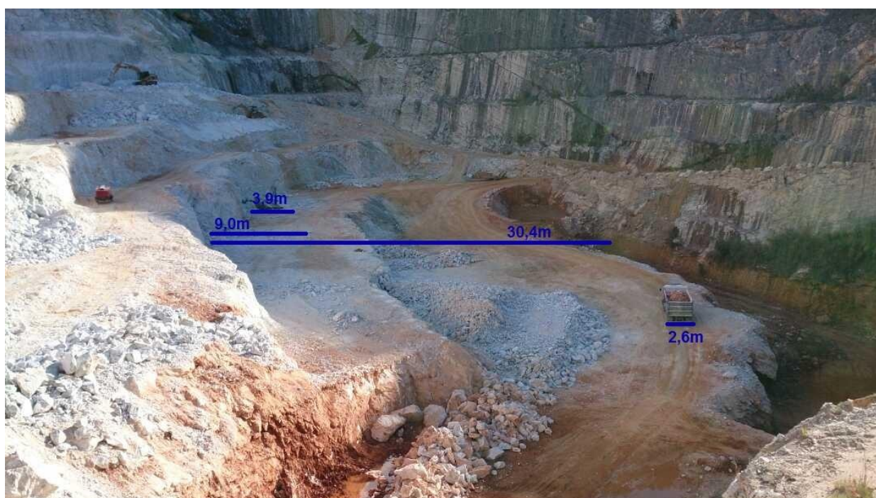
Figura 2 – Áreas desmontadas e distancias de ultralaçamento
